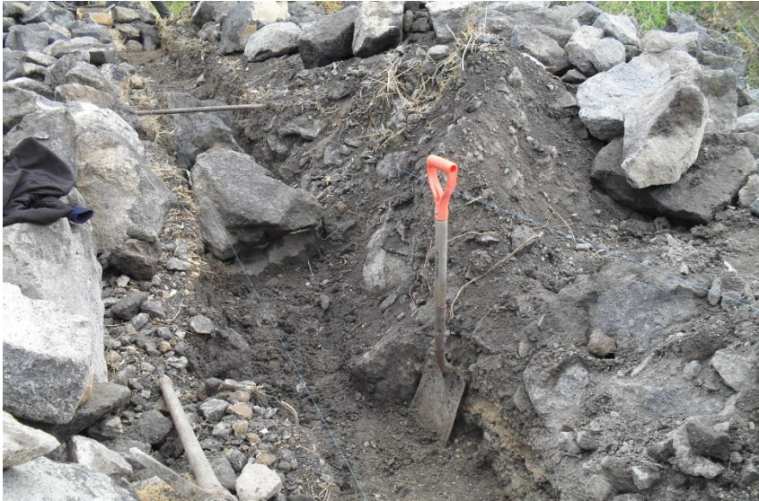
d) Levantar muro de piedra de 40 cm promedio de espesor
