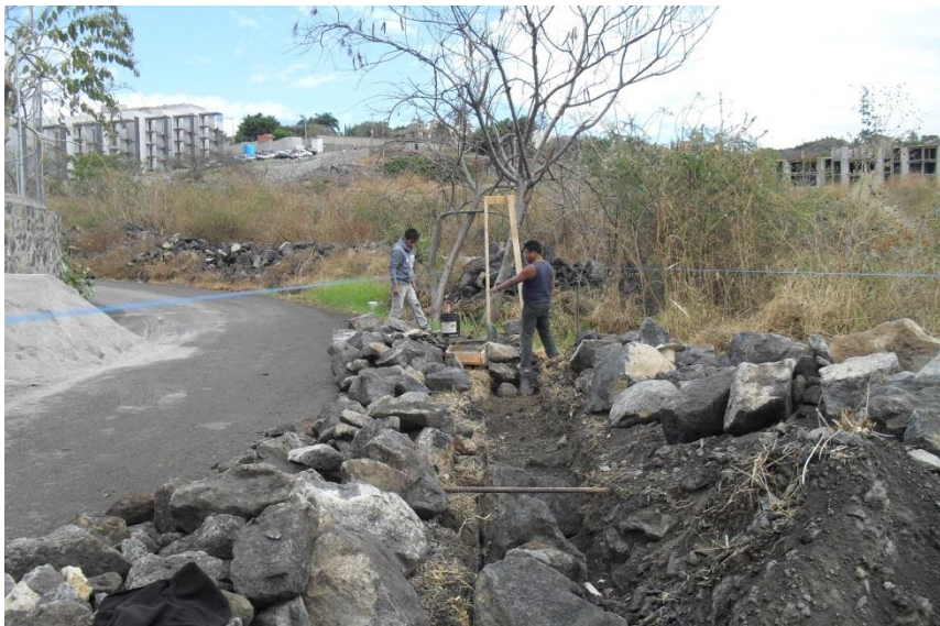
e) Inicio de construcción de muro
